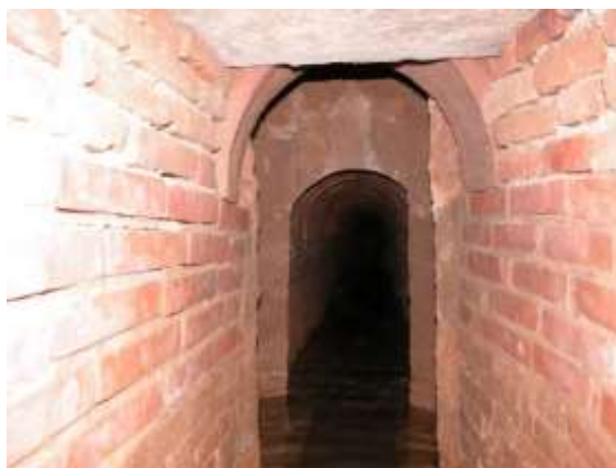
Figure 4-36: Public mine of Aigües de Terrassa. Qanat, Terrassa. Barcelona (Extracted from las Galerías drenantes en España: análisis y selección de Qanat(s) 2008).
