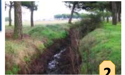
Canal de escorrentía procedente de Pedrajas
