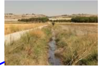
Canal de Infiltración nº2
