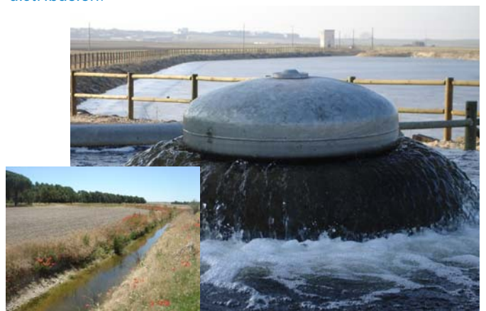
Imagen de la balsa y canal de recarga artificial del dispositivo de la Cubeta de Santiuste (Segovia)
