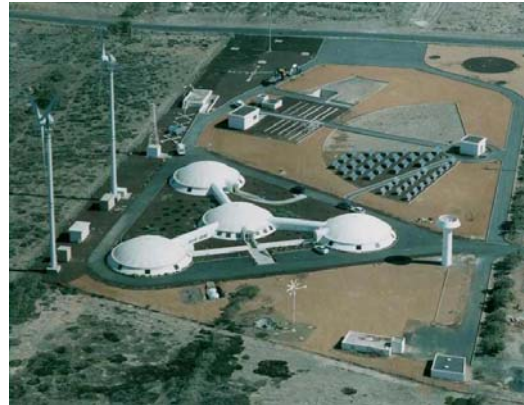
Desalinizadora eólica en Canarias
