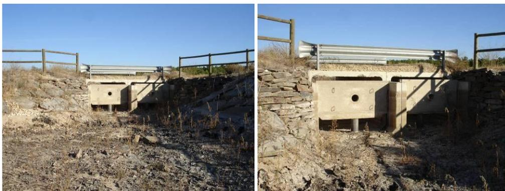
Figuras 11-2 a) y b). Dispositivos de parada que permiten el caudal fluyente a distintas alturas para minimizar el efecto *cascading* y la disolución de aire. Fotos: 15/10/2009.
