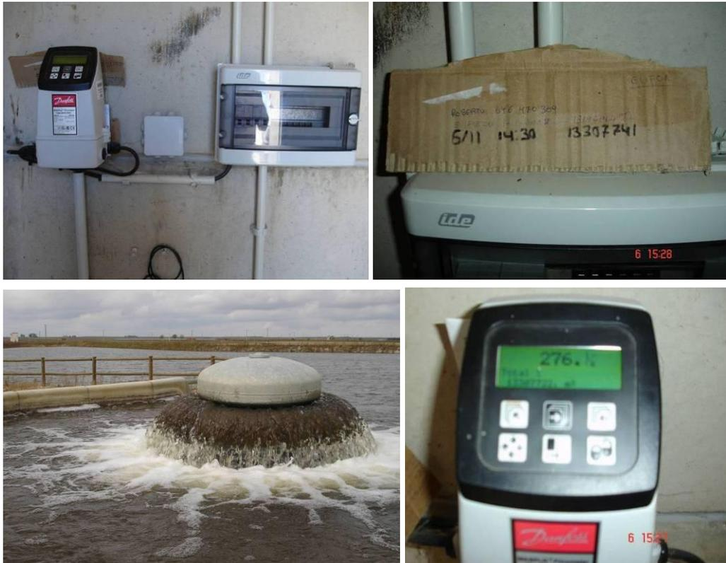
Figuras 10-6 a) a d). Registro manual de caudales sobre el caudalímetro totalizador instalado en cabecera.
