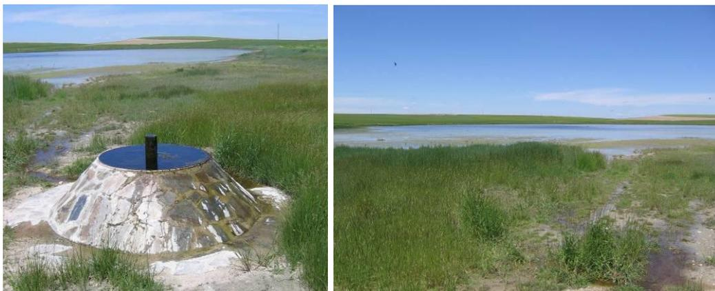
Figuras 15-1 a) y b). Fotografía de la laguna de la Iglesia tras las operaciones de regeneración hídrica iniciadas en el cuarto ciclo de recarga artificial. Detalle de la válvula de entrada (a) y aspecto general (b). Fotos de mayo de 2006.
