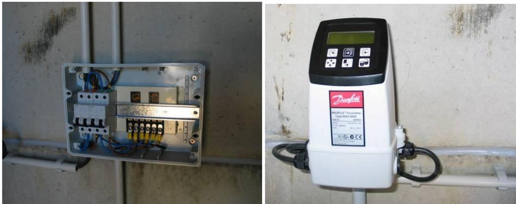
Figuras 5-7 a) a d). Elementos de control del caudal conducido en las inmediaciones de la cabecera del canal y elementos auxiliares. Caudalímetro por ultrasonidos intercalado en la conducción (a), caseta prefabricada para albergar la instrumentación (b), montaje eléctrico inicial (c) y caudalímetro totalizador Siemens (d).
