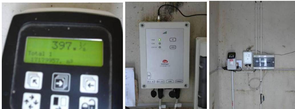
Figuras 11-5 a) a c). Caudalímetro totalizador (a), data-logger para el registro en continuo del caudal de entrada al dispositivo con volcado telefónico de datos (b) y configuración final (c). Fotos 04/03/2010 (a) y 01/04/2010 (b y c).
