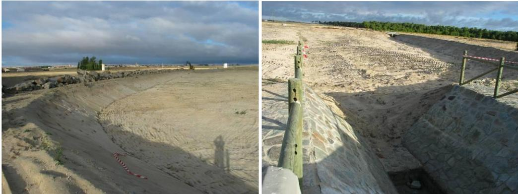
Figuras 6-2 a) y b). Aspecto de la balsa de decantación-infiltración de cabecera ampliada durante el verano de 2004 que empezó a funcionar con el inicio del tercer ciclo de recarga gestionada (año hidrológico 2004/05). Fotos 18/10/2004.
