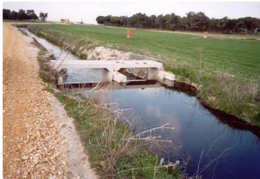
Figuras 2-30 a) y b). El canal tiene una sección de 1,5 m de altura, 1 m de anchura en la base y pendientes 1/1 a ambos lados. A lo largo del mismo se disponen las obras de parada construidas en hormigón armado y provisto de tajadera de 1 m de calado máximo y 0,50 m de mínimo en situación estática.
