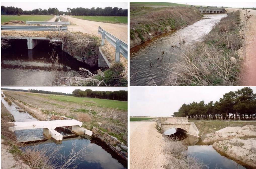
Figuras 5-2 a) a d). Dispositivos de parada y pasos del canal. Primer paso (ya inexistente) en el camino de Correlagua (a); cruce del canal en el Sanchón con la carretera de Santiuste a Coca (b); obra de parada y taludes verticales cubiertos por gaviones (c) y cruce del canal con la carretera de Coca a Villagonzalo (d). Fotos de fecha 18/03/2004.
