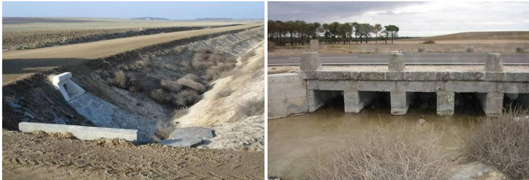
Figuras 7-7 a) a d). Obras de mejora: dispositivos de parada mejorados, gaviones y/o escolleras en los taludes, desviación al canal de excedentes mediante conducciones, muros de contención. Fotos de 01/02/2006 (a y b) y 15/02/2006 (c y d).
