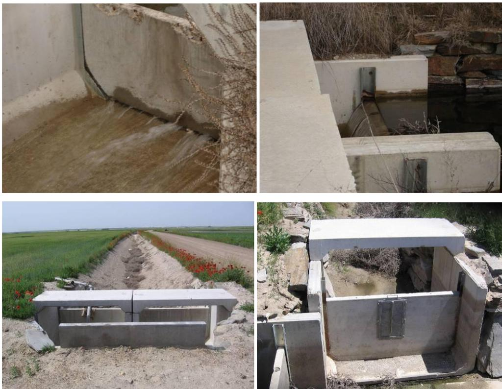
Figuras 7-4 a) a d). Mejoras en los dispositivos de parada para minimizar el aire disuelto en el agua de recarga por el batido de las aguas (a y b); instalación de pasos en los dispositivos de parada por "vasos comunicantes" (c) y provistos de compuerta (d). Fotos de 15/02/2006 (a y b) y 16/05/2006 (c y d).
