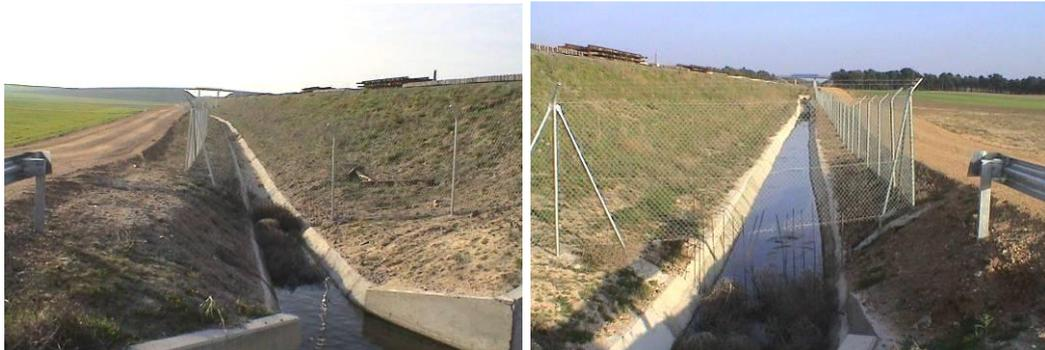
Figuras 5-5 a) y b). Drenaje de la vía del Tren de Alta Velocidad y estructuras asociadas en el paso del canal de recarga Este (o Viejo) bajo la vía. Vista hacia el oeste (a) y hacia el este (b). En este punto se ha aforado un volumen superior al de la estación anterior por aportaciones en forma de escorrentía superficial canalizada.
