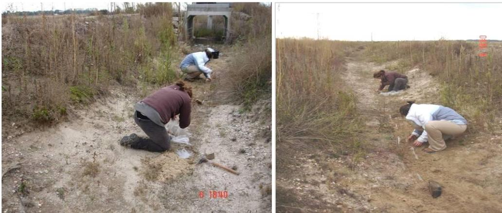
Figuras 10-3 a) y b). Instalación de geotextiles en dos tramos longitudinales de 5 metros semienterrados en la zona más profunda del canal, formando un caballón. Fotos: 30/10/2008.
