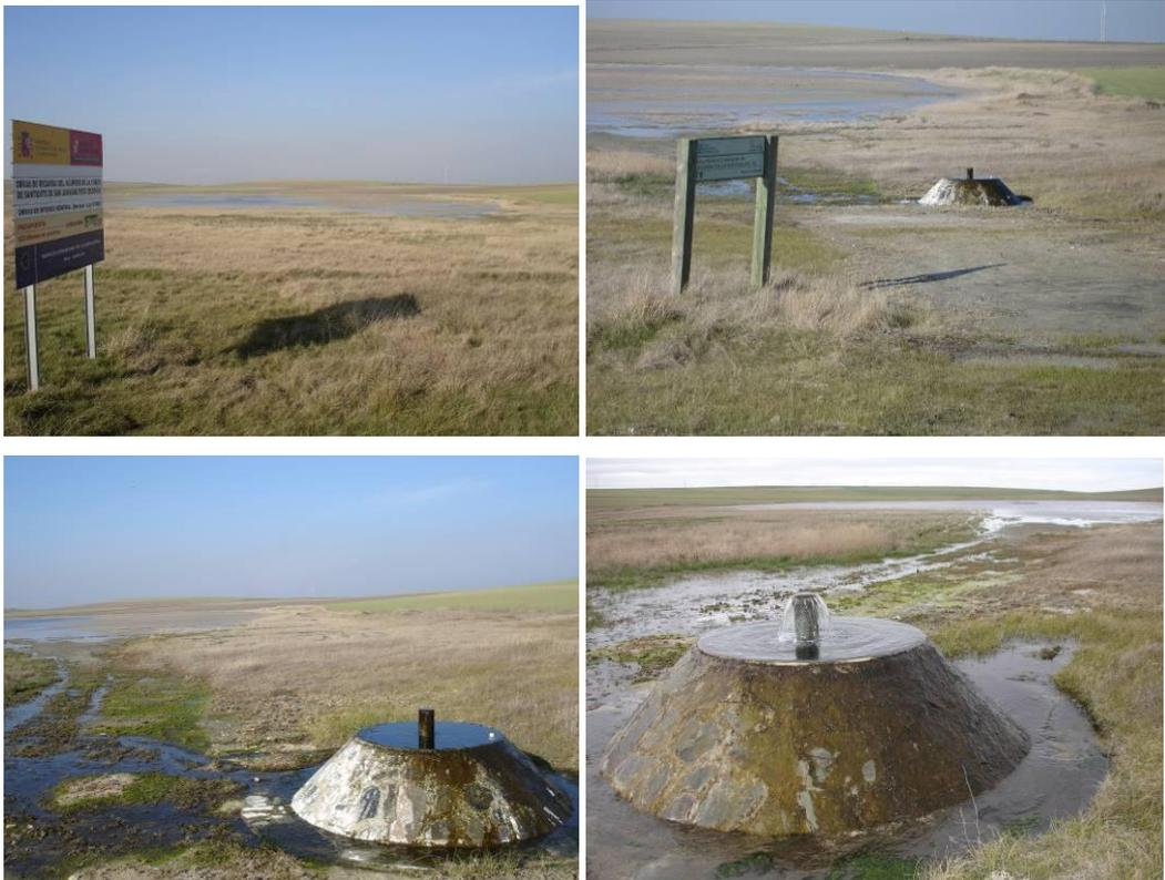
Figuras 7-5 a) a d). Actuación de regeneración hídrica en la Laguna de la Iglesia de Villagonzalo. El agua de recarga artificial se hace discurrir por el sustrato salino para aumentar su concentración en sales y originar aguas parecidas a las originarias. Fotos: 01/02/2006 (a a c) y 15/02/2006 (d).
