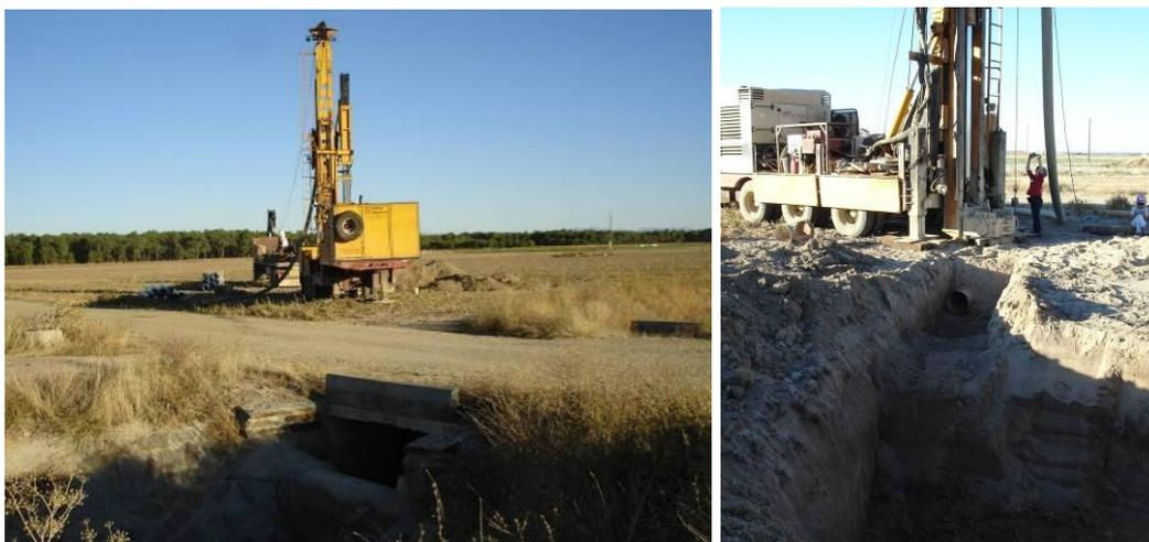
Figuras 13-4 a) y b). Instalación de la máquina para la perforación de dos nuevos sondeos de iniciativa privada en el paraje de Correlagua, que permitieron llevar a cabo un levantamiento detallado de sus columnas. Fotos: 12/10/2011.
