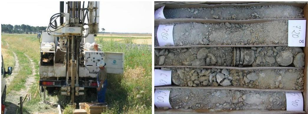
Figuras 4-4 a) y b). Perforación del piezómetro SW-7 y aspecto de una caja de testigo. 13/06/2003.
