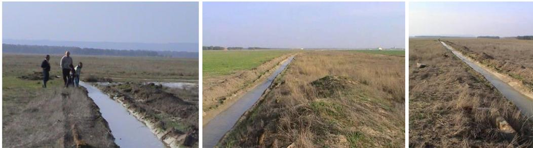
Figuras 6-7 a) a c). Ampliación del canal de recarga artificial hacia el norte de Villeguillo (Llanos del Cuadrón), zona de “rebosadero” del acuífero en la que antiguamente había varios humedales bien desarrollados, según los testimonios de la población local.
