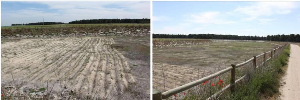
Figuras 10-1 a) y b). Labrado de caballones a distintas anchuras en la balsa de infiltración / decantación de cabecera. Fotos: 27/05/2009.
