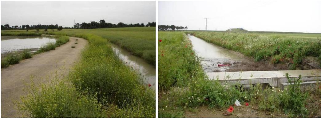
Figura 8-6 a) y b). Pequeños desbordamientos del canal de recarga e inundación de zonas puntuales de terreno de labor. Fotos: 24 de mayo de 2007.
