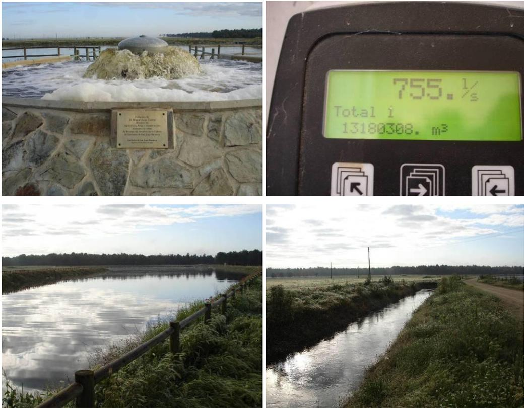
Figuras 9-1 a) a d). El sexto ciclo de recarga terminó después de la fecha de concesión habitual, como consecuencia de la irregularidad de las precipitaciones. Cabecera del dispositivo con un caudal de entrada superior a 750 l/s (a), caudalímetro totalizador (b), balsa de decantación/ infiltración (c), y cacera de Correlagua (d). Fotografías de fecha 02/06/2008 (a) y 06/06/2008 (b a d).
