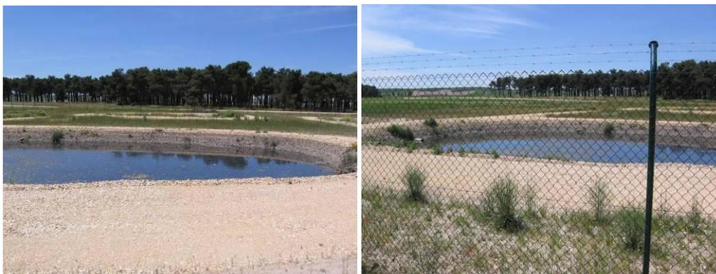
Figuras 7-3 a) y b). Balsas de infiltración empleadas para la depuradora de lagunaje, acondicionamiento y vallado. Fotos: 01/02/2006 y 16/05/2006 respectivamente.
