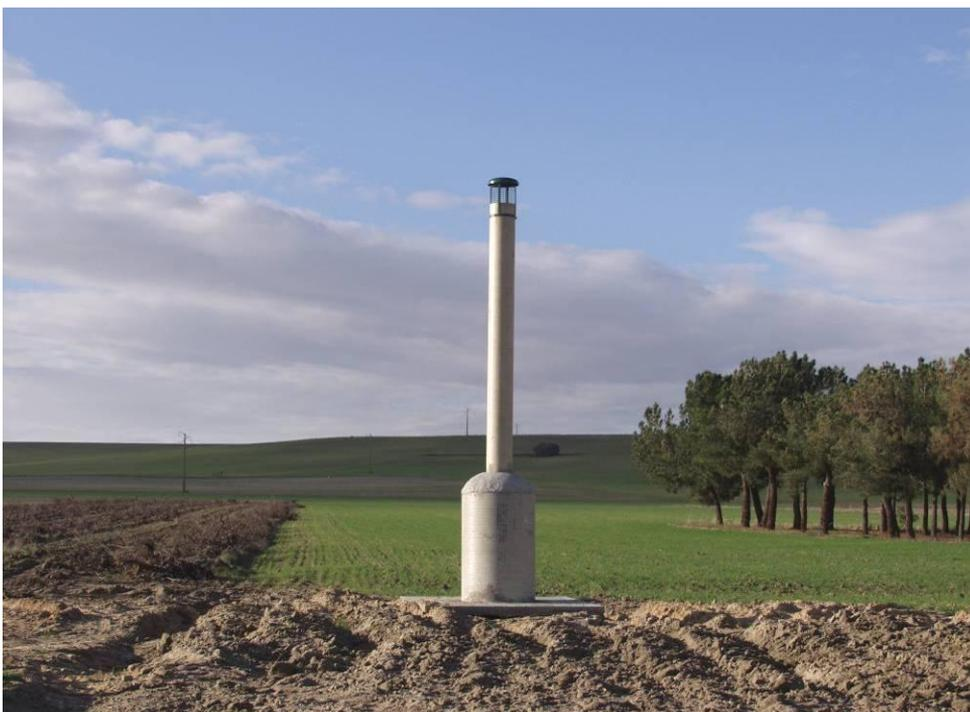
Figura 2-29. Chimenea de aireación. La presa queda conectada con la cabecera del dispositivo de AR mediante una tubería de más de 9 km de longitud, en la que hay intercalados dispositivos de disipación de energía para evitar el golpe de ariete.
