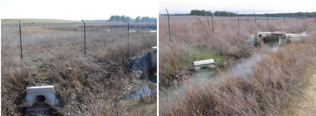
Figuras 10-4 a) y b). Zona de vertido de las aguas depuradas procedentes de la depuradora por lagunaje en el canal de recarga Este. Analizando la calidad de las aguas, estas se ajustaban a los requerimientos del RD 1.620/2007. Fotos 13/02/2008 y 13/04/2008.
