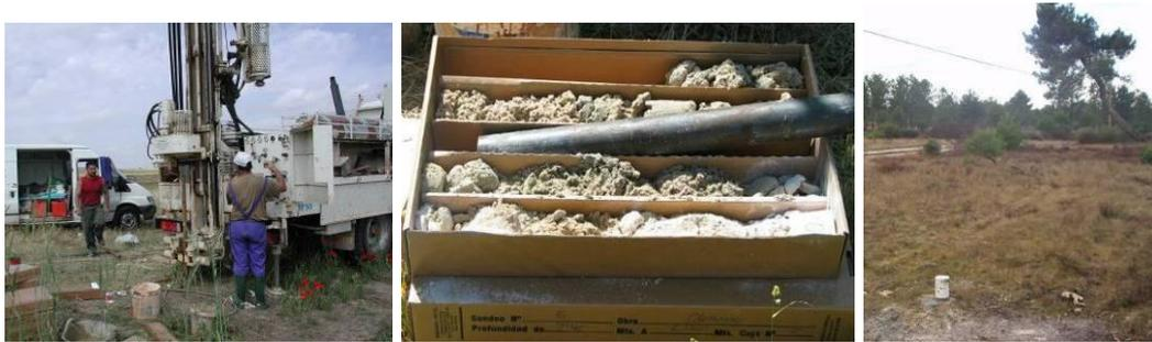
Figuras 2-25 a) a c). Perforación del piezómetro SW-7 por rotación con extracción de testigo continuo. Aspecto final del piezómetro SW-4. Fotos 18/12/2002.
