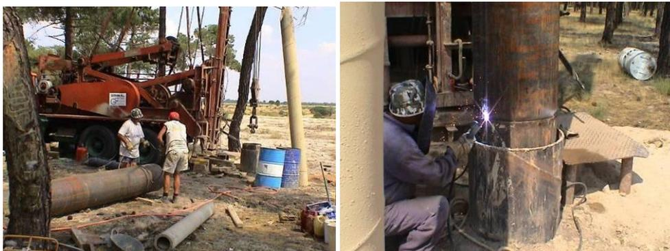
Figuras 4-5 a) y b). Momentos durante la perforación y entubación del sondeo de investigación P-3. Foto: 07/08/2003.
