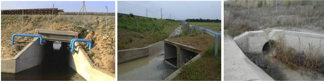
Figuras 8-3 a) a c). Drenaje de la vía del Tren de Alta Velocidad, estructuras asociadas y paso del canal de recarga bajo la vía (a y b). Vertedero en uve (c).
