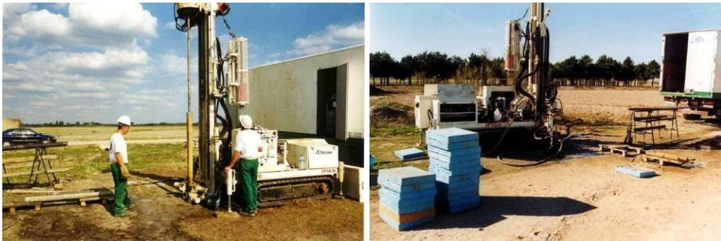
Figuras 2-24 a) y b). Perforación del sondeo SW-3 mediante rotación con extracción de testigo continuo.
