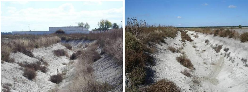
Figuras 9-3 a) a d). Obras para atravesar la localidad de Villeguillo con el canal de recarga gestionada, aprovechando el trazado del antiguo arroyo de la Ermita. Extremo sur de la localidad, llegada del canal y emboquille de la obra de soterramiento (a y b). Afloramiento al norte de la localidad, junto al cementerio y obras de prolongación hacia el norte (c y d). Fotos de fecha 11/10/2007.
