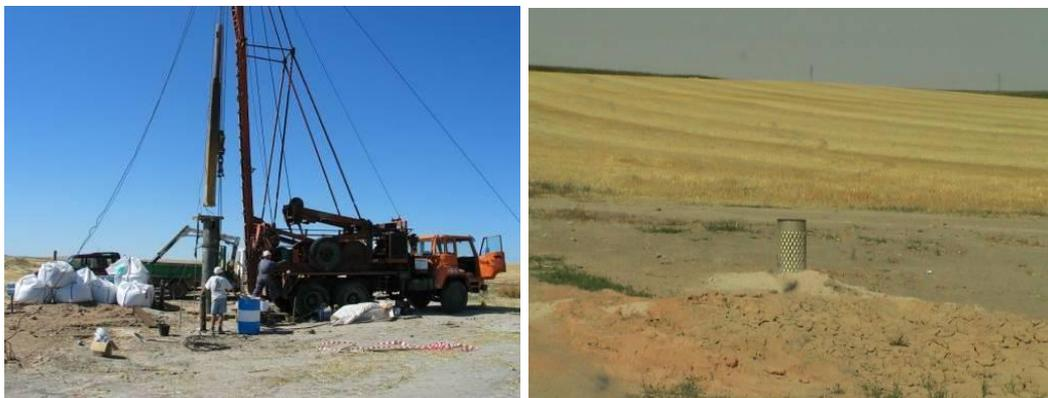
Figuras 2-26 a) y b). Perforación a percusión del sondeo P-4, y aspecto de sondeo P-2 ya finalizado. Fotos: 06/08/2003.
