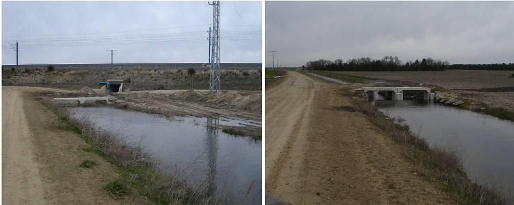
Figuras 9-5 a) y b). Evento de caudales máximos que llegó a sobrepasar la altura de algunas compuertas de parada. Fotos de fecha 06/03/2007.
