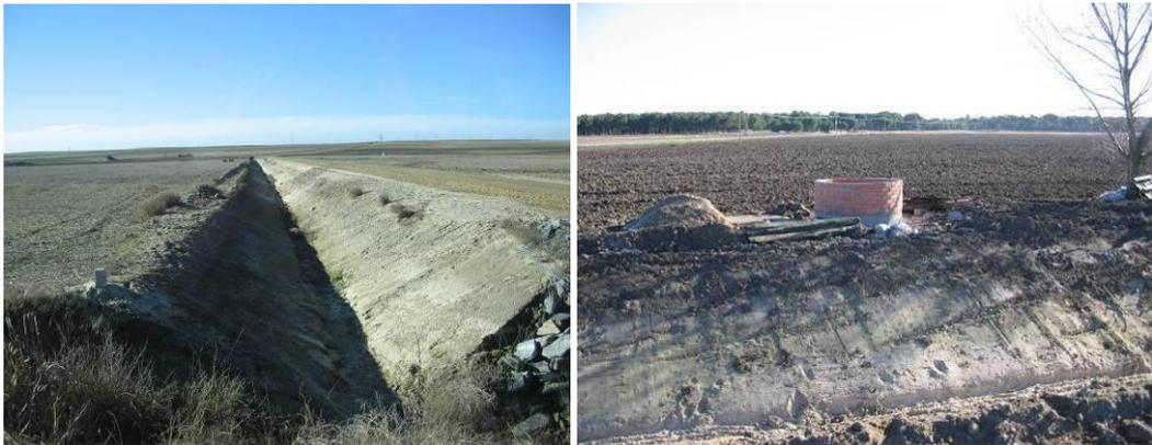
Figuras 6-5 a) y b). Modificaciones en el diseño inicial del canal Este, con cambios en los taludes, revestimientos y apertura de la curvatura en tramos donde se registraban fuertes procesos erosivos. Asimismo se construyeron nuevos pozos en las inmediaciones del canal. Fotos tomadas el 18-01-05.
