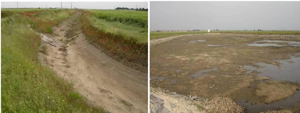
Figuras 8-4 a) y b). Modificaciones en el canal de recarga, en general con tendencia a aumentar el eje de giro en las curvas e inicio de los estudios de los procesos colmatantes en la balsa de decantación/infiltración. Fotos: 22/05/2007.
