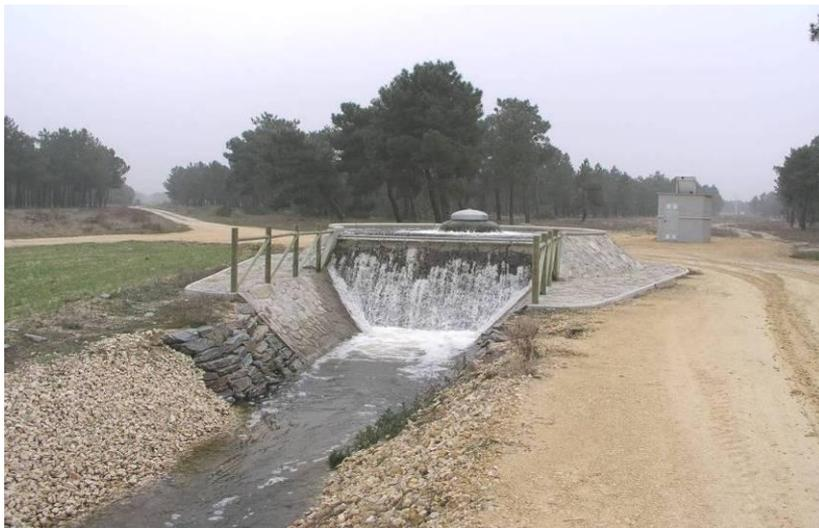
Figura 5-8. Cabecera del dispositivo al término del segundo ciclo, con taludes revestidos y vertido de grava calcárea para preservar la estructura y elevar ligeramente su pH inicial. Foto: 01/04/2004.
