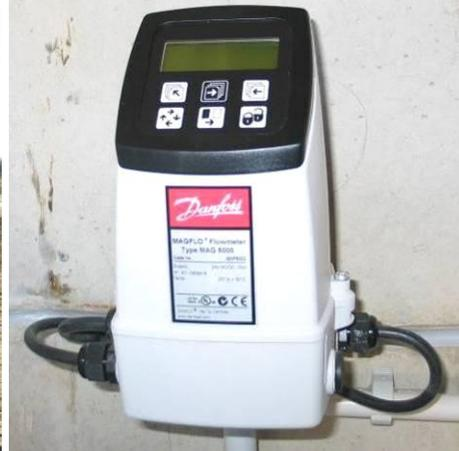
Figuras 2-28 a) a d). La cabecera del dispositivo debe ir dotada de un caudalímetro totalizador, preferentemente con medida en continuo, intercalado en la tubería de recarga antes del dispositivo de entrada. Su protección es llevada a cabo mediante una garita de hormigón y su alimentación mediante paneles fotovoltaicos. Es recomendable su medición en continuo y teleenvío de datos.
