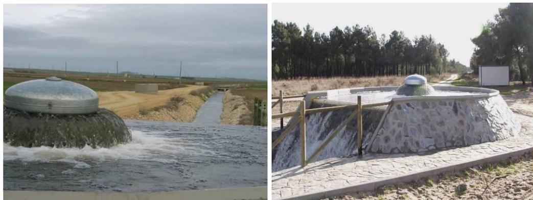
Figuras 5-1 a) y b). Cabecera de un dispositivo tipo canal en Santiuste de San Juan Bautista (Segovia). Válvula, canal, pozos en la vía de servicio y primer dispositivo de parada. Fotos de fecha 23/01/2004 y 18/03/2004.
