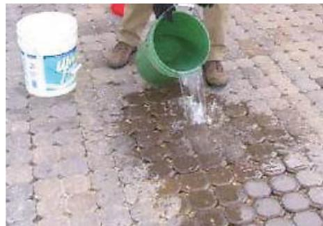
Figura 88. Adoquines con grava en la junta.
