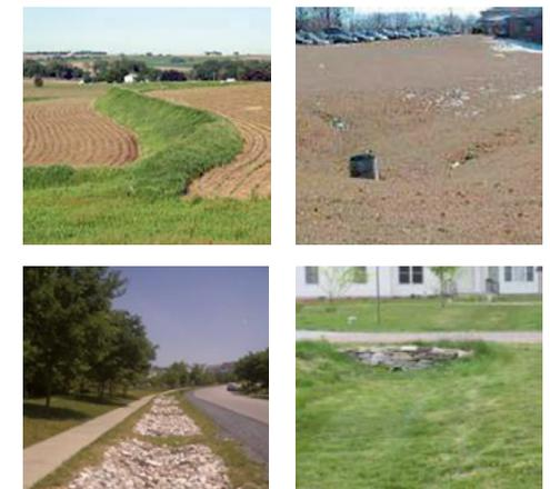
Figura 39. Banda filtrante, balsa de detención, cuneta rellena y cuneta verde.
