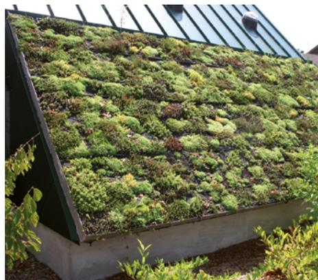
Figura 140. Cubierta intensiva inclinada.
