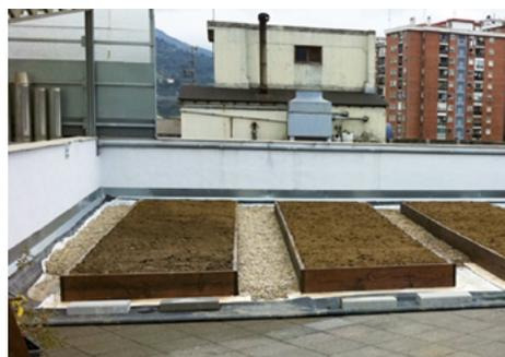
Figura 159. Elementos unitarios en una cubierta plana.
