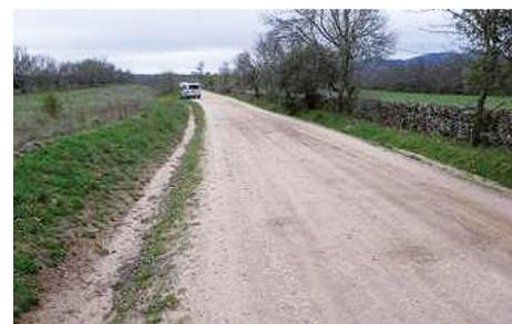
Figura 246. Cuneta con materia granular de relleno.
