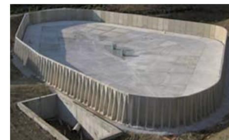
Figura 51. Depósito prefabricado de la Planta de Prefabricados de Tragsa.
