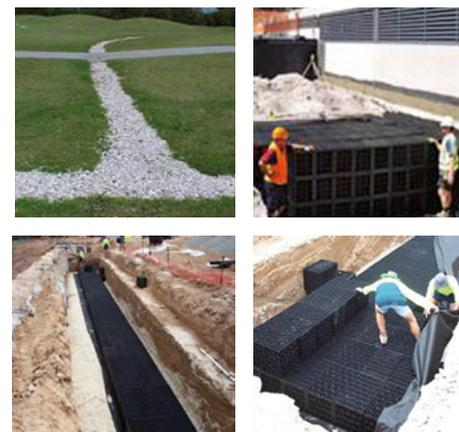
Figura 40. Zanja y depósitos de infiltración.
