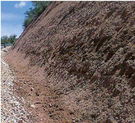
Figura 236. Talud lateral erosionado.
