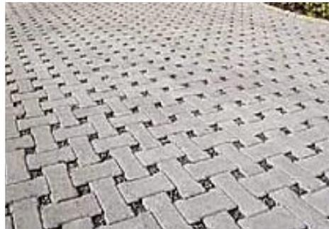
Figura 87. Adoquines con junta abierta permeable.
