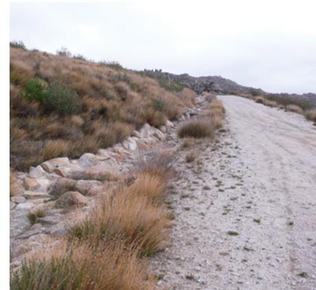
Figura 238. Cuneta impermeable.
