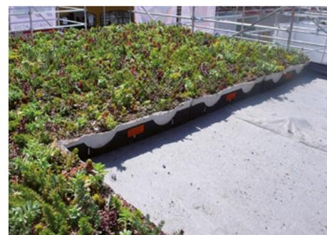
Figura 137. Elementos precultivados modulares.
