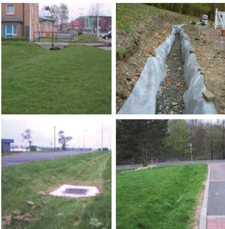
Figura 232. Franja de infiltración, drenaje de arcén y cunetas verdes.
