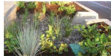
Figura 97. Alcorques con franjas de biorretención.
