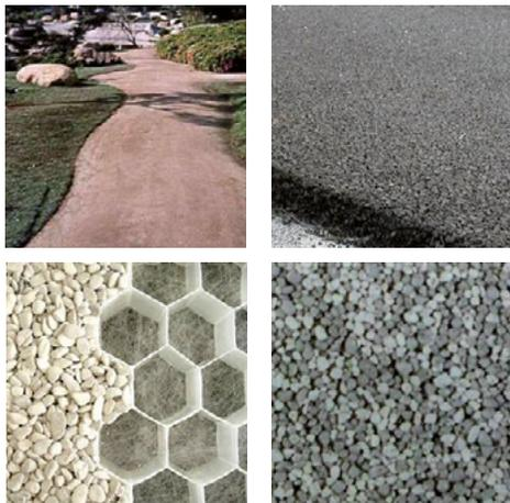
Figura 65. Pavimentos continuos: tierra compactada, asfalto poroso, celda rellena de grava, grava estabilizada.
