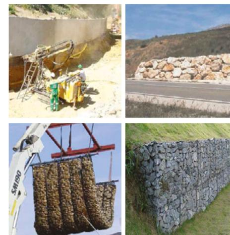
Figura 225. Sistemas de contención vertical.
