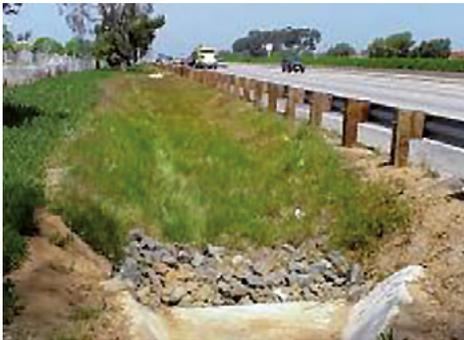
Figura 37. Zanja de biorretención.
