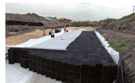
Figura 52. Depósito modular enterrado.
