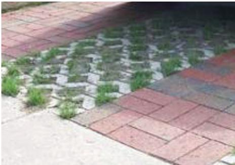
Figura 73. Ejemplo de aparcamiento permeable.
