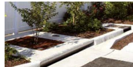
Figura 99. Sistema prefabricado de biorretención.
