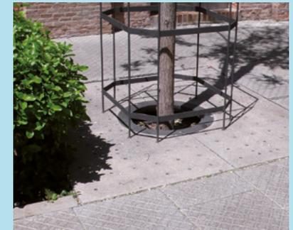
Figura 67. Alcorque permeable.
