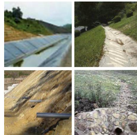
Figura 231. Canal de guarda, canal intermedio, drenaje horizontal y subdren de zanja.
