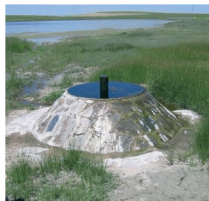
Figura 8. Regeneración hídrica de la laguna de la Iglesia en mayo de 2005 y detalle del dispositivo de entrada (conocido como "hongo"). Laguna de la Iglesia, Coca (Segovia).
