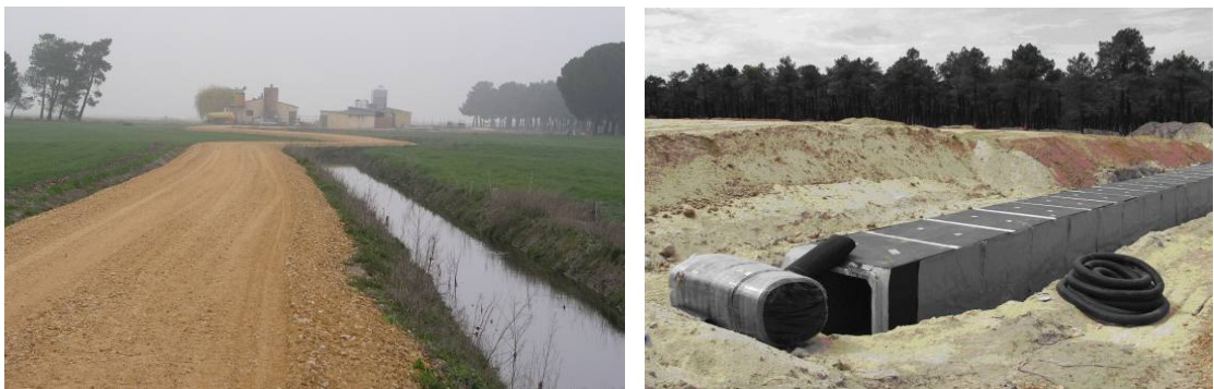
Figura 16. Aspecto de la cabecera del dispositivo y del camino de servicio del caz de recarga artificial.
