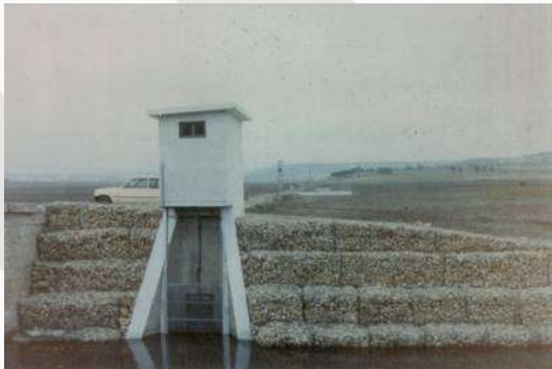
TOMA DE AGUA DEL RÍO
