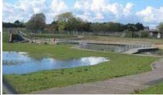
Depósitos y estanques de infiltración
