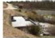
Decantador en cárcavas
