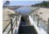
Decantadores en boca de Desembocadura
