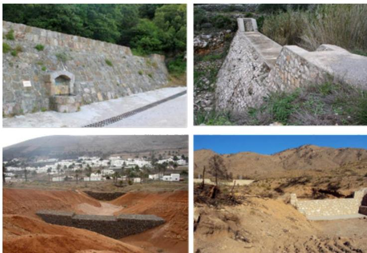
Ejemplos de estructuras de detención-infiltración en España (Tarragona, Alicante, Lanzarote y Toledo respectivamente)
