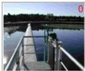
0- Toma de aguas del río Voltoya
