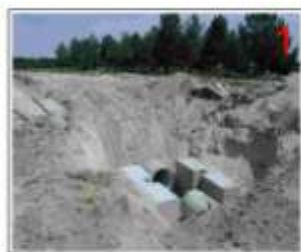
1- Tubería de conducción
