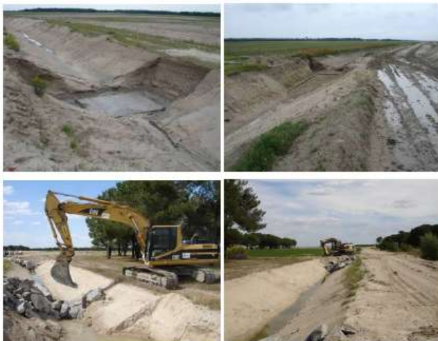
Figuras 8-5 a) a d). Obras de prolongación del canal desde los Llanos del Cuadrón al Medianero (Llano de Olmedo). Fotos: 22/05/2007 (a y b) y 28-06-07 (c y d).
