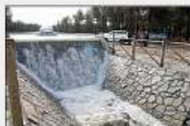
Lugar donde brota el agua y comienza la recarga de la cubeta de Santiuste de San Juan Bautista (PENALOSA).
