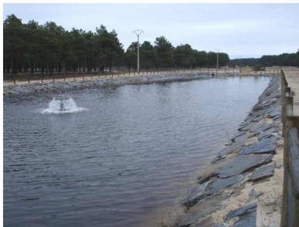
Balsa de infiltración de un dispositivo MAR para riego
