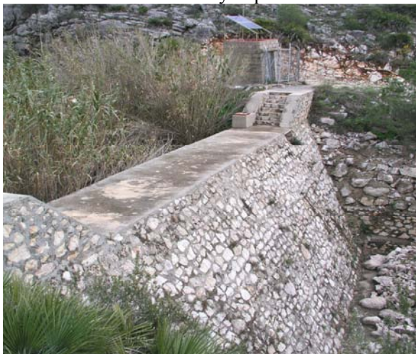
Presa para aumentar la recarga de los acuíferos en áreas forestales
