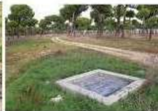
Aliviaderos para conducir excedentes a campos de infiltración
