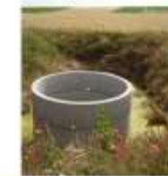
NO CIERRES UN POZO: "REUTILÍZALO" (conexión al canal de recarga mediante tubería y relleno de grava)
