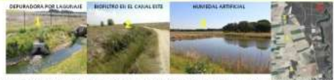
"TRIPLETA" DE SANTIUSTE: DEPURADORA-BIOFILTRO- HUMEDAL ARTIFICIAL (2 km)
