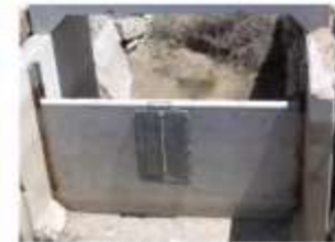
Solución tecnológica en los dispositivos de parada para evitar el batido del agua
