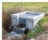
Colector de infiltración
