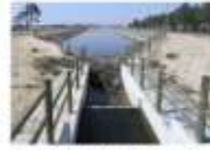
Decantadores en boca de Desembocadero
