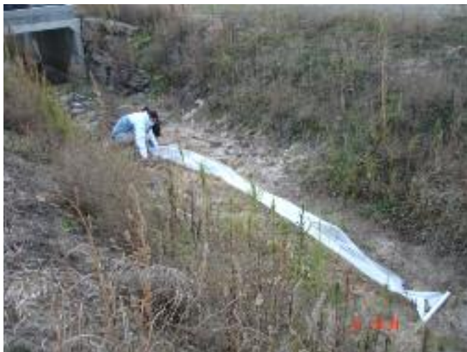
Figuras 13 a) y b). Instalación de geotextiles en el fondo del canal de recarga artificial de la cubeta de Santiuste el 07-11-08. Figures 13 a) & b). Geotextils installation in the bottom of the AR channel at Santiuste basin on 2008 November 7th.
