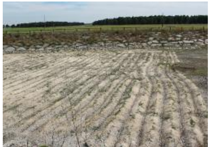
Figuras 11 a) y b). Caballones arados con distinta anchura en el fondo de una balsa de decantación e infiltración (cabecera del dispositivo de la Cubeta de Santiuste).
