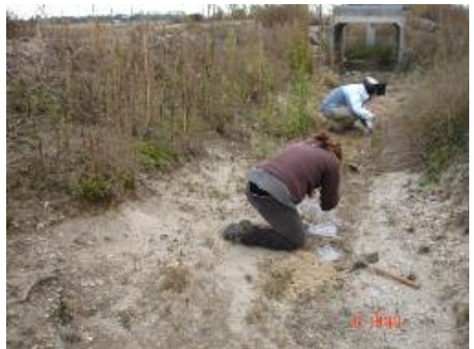
Figuras 13 a) y b). Instalación de geotextiles en el fondo del canal de recarga artificial de la cubeta de Santiuste el 07-11-08. Figures 13 a) & b). Geotextils installation in the bottom of the AR channel at Santiuste basin on 2008 November 7th.
