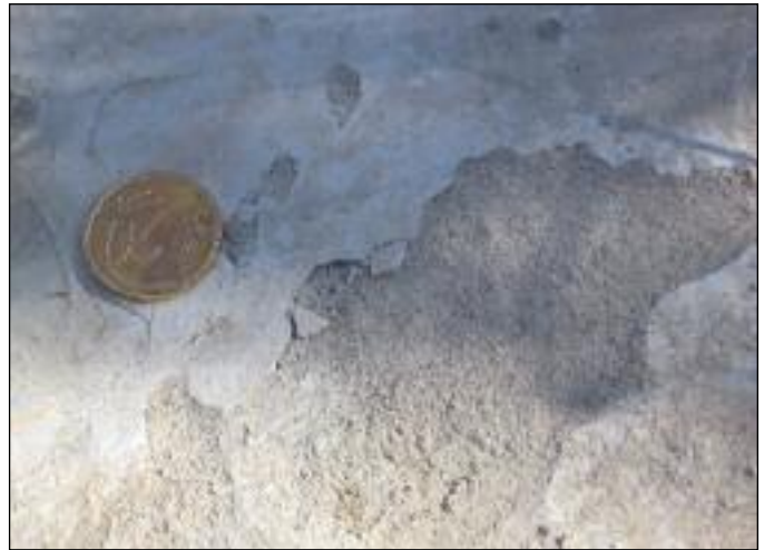
Figuras 4 a) y b). Precipitados de carbonato en el fondo del canal "oeste" (punto IN-11). Figures 4 a) y b). Carbonate precipitation in the bottom of the artificial recharge West channel (IN-11 testing point).
