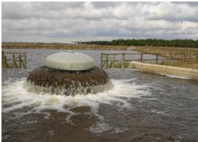
Figura 10. Aspecto de la cabecera del canal con un caudal de entrada superior a 750 l/s (Santiuste, 2 de junio de 2008). Figure 10. Aspect of the headwaters of the canal with a flow rate of entry major than 750 l/s (Santiuste, June 2th, 2008).
