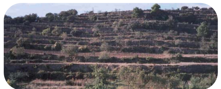
Ladera abancalada. Gran cantidad de estas obras de corrección están hoy día abandonadas. Su mantenimiento y repoblación forestal facilitan el aprovechamiento de las aguas de escorrentía. Morella (Castellón). (Foto TRAGSATEC).
