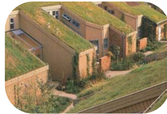
Depósitos de infiltración.
