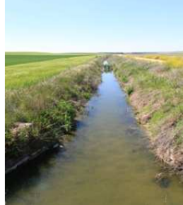
Canal de recarga en Santiuste, Segovia.
