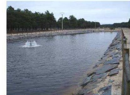
Balsa de infiltración de un dispositivo MAR para regadío
