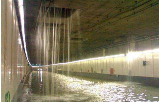
Trampas de escorrentía
